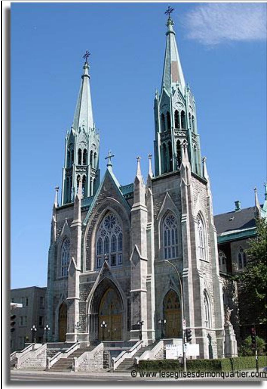
Église Saint-Édouard (Montréal) Photo : Monique Bellemare - Paroisse érigée en 1895 - 6500 rue St-Vallier, Montréal, Qc, H2S 2P7
